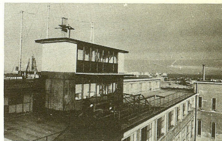
Huset er udført af træ- og PVC-materialer. Vinduerne i husets øverste del er af plexiglas, da almindeligt vinduesglas indeholder bly.
