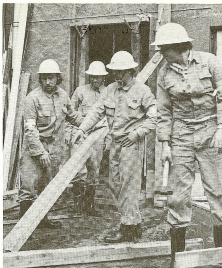
Fire af bedriftsværnets medlemmer er i færd med afstivninger under øvelsen på Industrigården.
