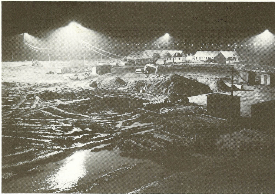
På Herregårdsvej i Roskilde har Philips assisteret entreprenøren med beregninger af belysningsanlægget, så det er både energivenligt og i overensstemmelse med arbejdstilsynets krav.
