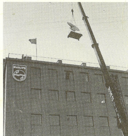
Med opsætningen af parabolantennen tog Philips Radio for alvor hul på fremtiden. Den er til interne tekniske forsøg med satellit-TV.
