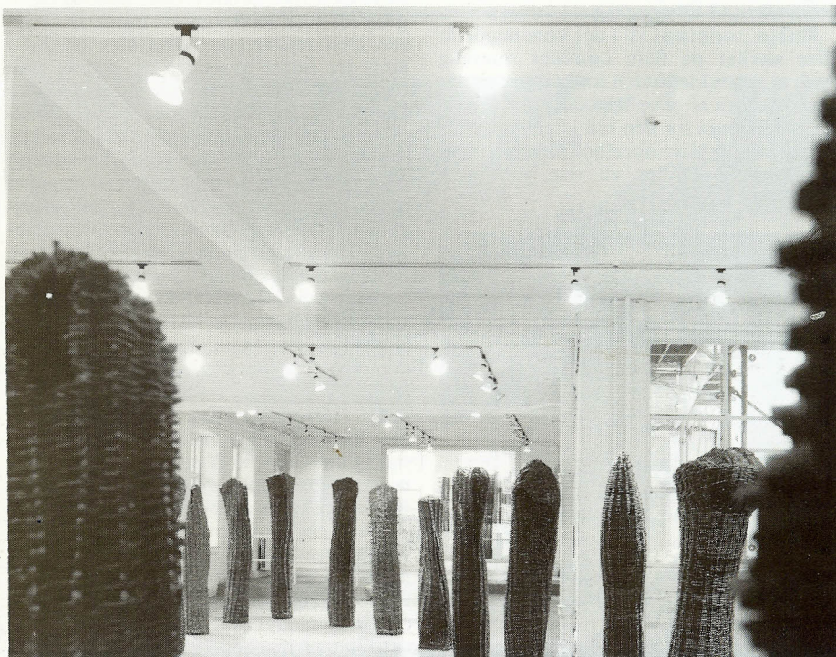
Belysningen i Kulturministeriets kunstudstilling på Christianshavn er udført med ACS grundspot. De er monteret på specielt udviklet skinnesystem, som ses på billedet til venstre.
